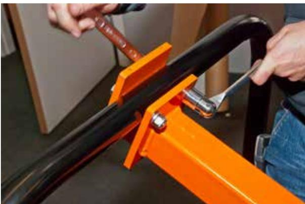
8. Zusammenbau Gleitbahn. Beginne mit der Montage beim Rohrbogen mit **2 x M10 x 80 + M10 Sicherungsmutter** sowie **M10 Scheibe** auf Seite der Mutter.
