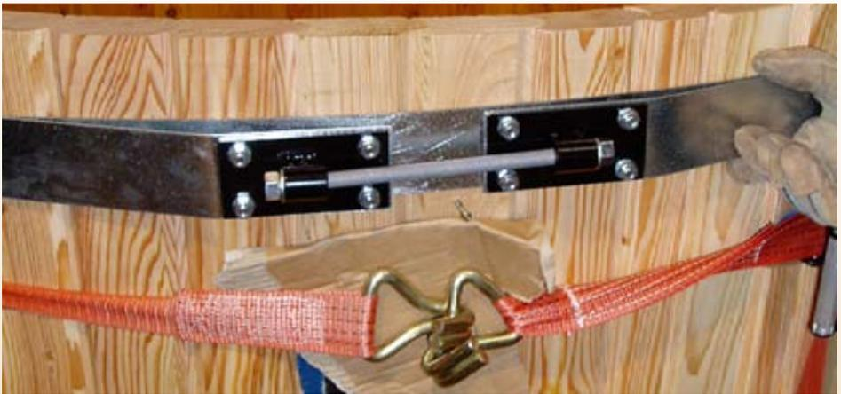
*Die Muttern können nur auf der Gewindestange befestigt werden, bevor sie angezogen wurden. Das abgeschnittene Stück Metallreifen wird unter die Schraubverbinder gelegt. Das Stück Karton unter dem Spanngurt schützt die Seitenbretter. Der Metallreifen sollte so angepasst werden, dass er auf den Stützschrauben liegt. Eine dieser Schrauben ist auf obigem Photo unter der Gewindestange zu sehen.*
